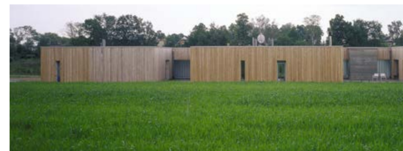
po lewej: patia wycięte w bryle od strony północnej przypominają pustkę po położonym wiatrem zbożu; nota bene z budynkiem od strony północnej sąsiaduje łan zboża
