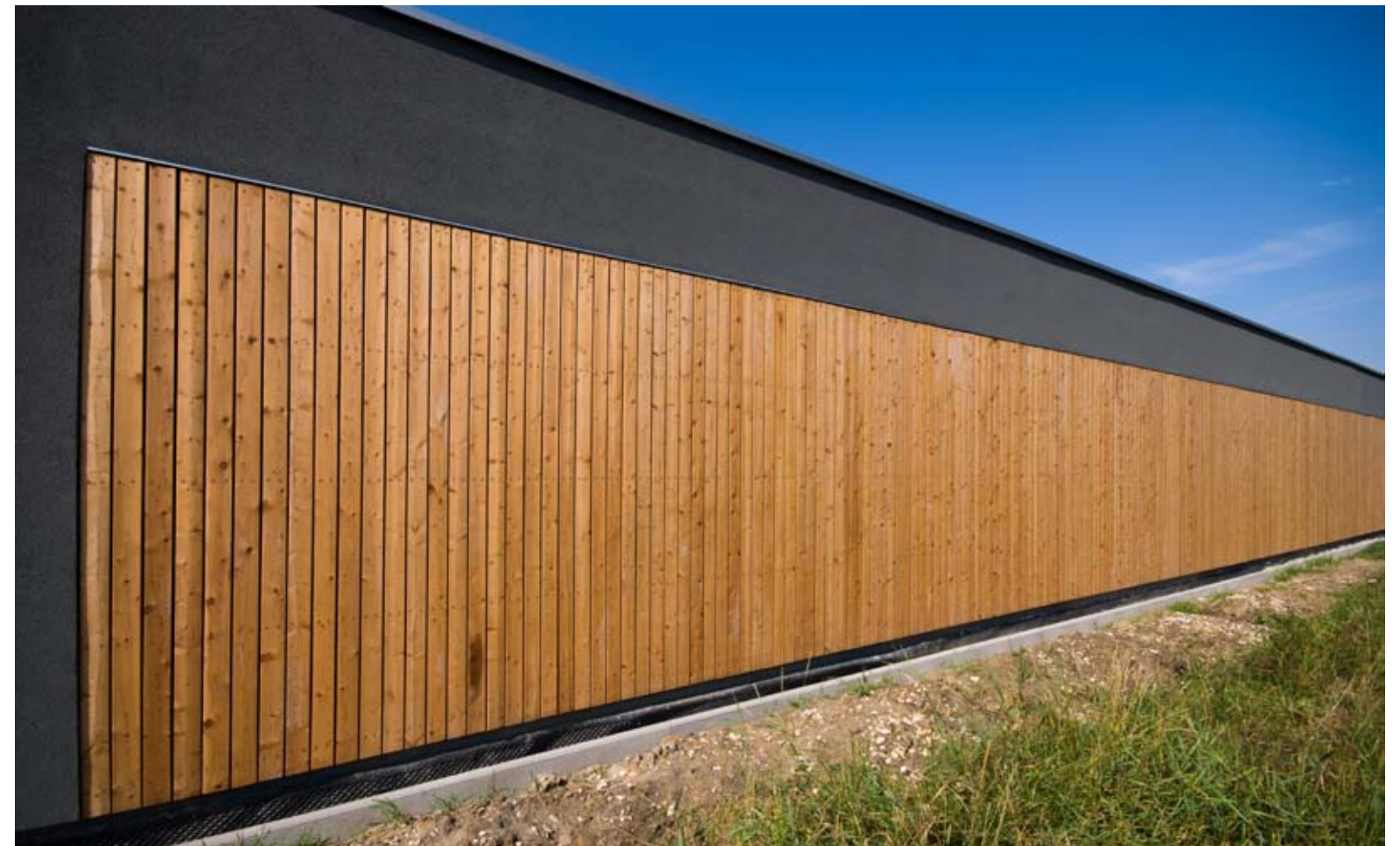
Fațada nord (detaliu) / Northern façade (detail)
