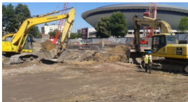
Najnowsze wieści z budowy biurowca .KTW
